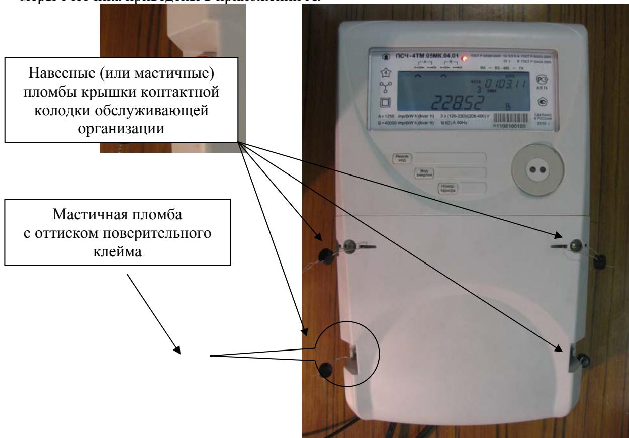
Рисунок 1 - Внешний вид счетчика ПСЧ-4ТМ.05МК
